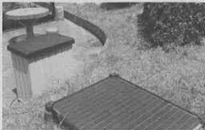
●屋上庭園に設置した遠隔管理システム（円内） ●太陽光発電機を搭載
