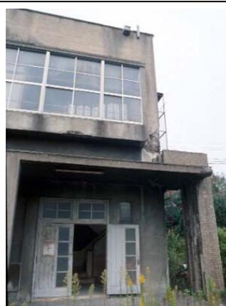
神鋼鋼線工業の旧中浜変電所は昭和10年前後に建てられた元日本発送電の変電所であった。装飾を排除したモダンスタイルの建築で、鉄筋コンクリート造の2階建て。外観の特徴は全面ガラスの連続窓とタイルによる構成主義的なスタイルが用いられている。ガラスの壁面が柱の位置よりも外にとびだしており、タイルは薄茶色のモザイクタイルを使うなど、モダンデザインの色彩が濃い建築である。
