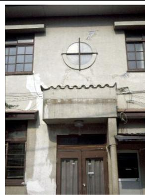
シオエ製薬株式会社尼崎工場で、現在研究棟として使われている旧事務所は木造2階建てでスパニッシュスタイルの外観をもつ珍しいもの。大理石に似た表面に仕上げたスタッコ壁やスパニッシュ瓦と呼ばれる茶褐色のS字型瓦、丸窓、丸柱などに特徴がある。
