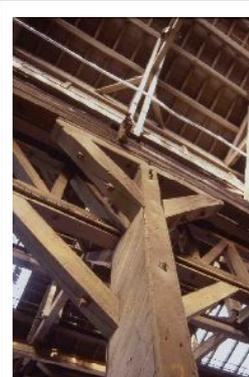
精機工業所は、事務所以外のすべての工場施設が昭和14年竣工時のままに使用されているきわめて珍しい工場といえる。木造で、屋根は人造スレートぶき、木の部分には白色系のペイントが塗られるなどメンテナンスがいきとどいており、木造ならではの柔らかい空間が作りだされている。中央部の屋根は採光と換気のために一段と高くなっている。トップライトから差し込む太陽光が淡く反射し、屋根を支える木造トラス構造ならではのダイナミックな空間となっている。
