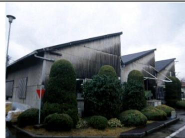
神崎高級工機製作所本社工場には、昭和10年代に建設された食堂とのかごり屋根の工場、切妻屋根の工場が残っている。食堂は木造トラス構造により、広い空間が確保されている。ある年代のかたがたにとっては、懐かしいのかごり屋根の工場は、北側から安定した光をとりいれるように工夫された形である。
